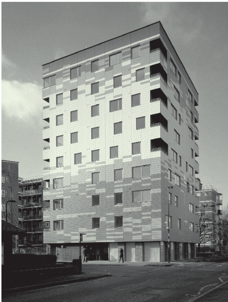
SLIKA 2 Drvena devetospratnica u Londonu izgrađena 2009. Izvor: Techniker.
